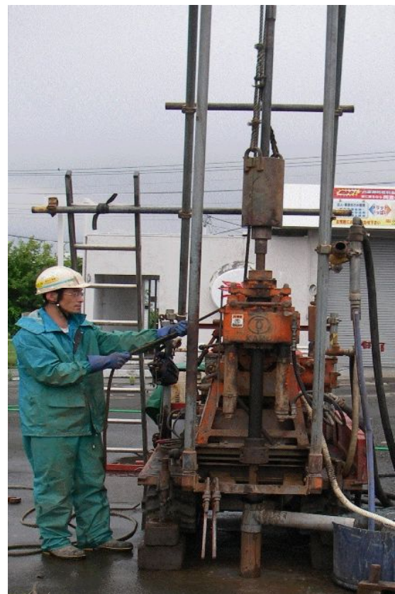
ボーリング調査
