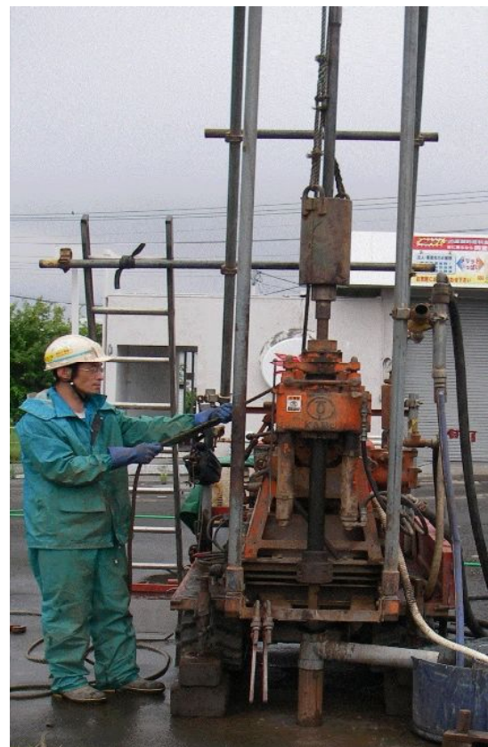
ボーリング調査
