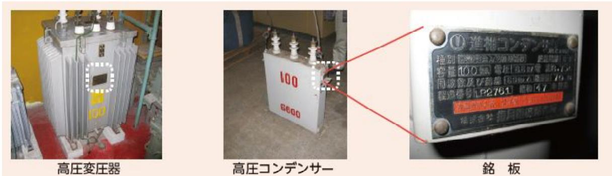
※銘板確認のため、通電中の変圧器・コンデンサーに近づくと感電の恐れがあり、大変危険です。必ず電気保安技術者に依頼して確認して下さい。
