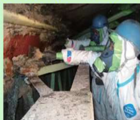
吹付け石綿の除去作業の様子
